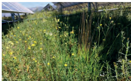
Photo 13 : Centrale photovoltaïque du Castellet (83) (© Voltalia)
