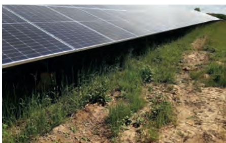
Photos 51 à 55 : Chantiers de construction d'une centrale photovoltaïque (© Neoen, © Idele, © science-in-hd/Unsplash)
