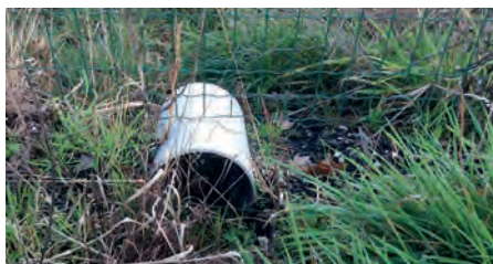
Photo 40 : Exemple d'aménagement dans la clôture pour le passage de la petite faune sauvage (© Idele)
