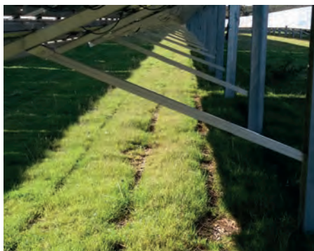
Photo 32 : Table fixe sur mono-pieu battu (© Idele)
