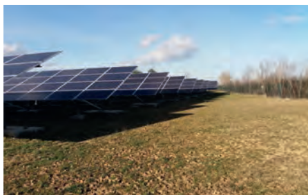
Photo 57 : Centrale photovoltaïque de Sainte-Agathe La Bouteresse (© Idele, centrale gérée par Neoen)
