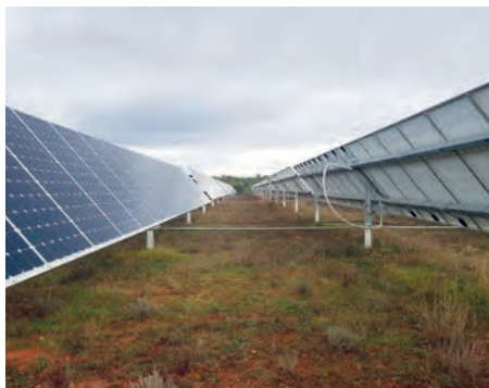
Photo 18 : Barres de commandes de panneaux trackers 1 axe pouvant éventuellement compliquer la co-activité avec l'élevage selon leur hauteur (si < 80 cm du sol) (© Idele)
