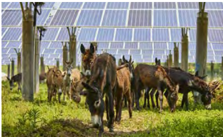
Photo 22 : Des ânes pâturent dans une centrale photovoltaïque avec des tables à plus de 1 mètre (© Jeson_AdobeStock)
