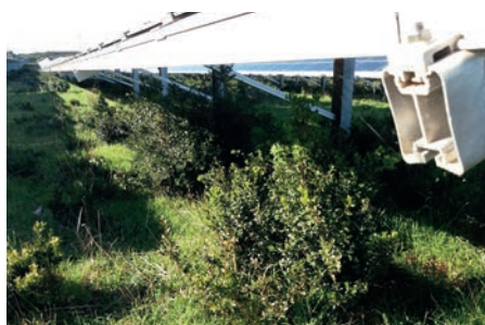
Photo 27 : Buissons invasifs non consommés par les brebis, à terme nuisibles pour les performances du parc (©Idele)
