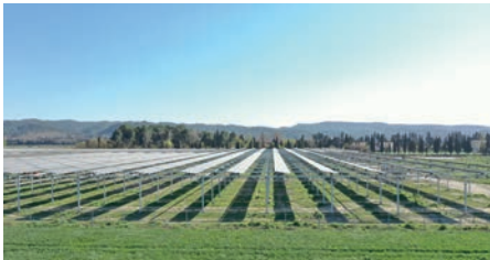
Photo 1 : Ombrières photovoltaïques installées au dessus de cultures maraîchères (© Voltalia)
