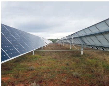
Photo 18 : Barres de commandes de panneaux trackers 1 axe pouvant éventuellement compliquer la co-activité avec l'élevage selon leur hauteur (si < 80 cm du sol) (© Idele)
