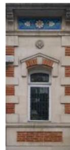
L'encadrement est soigné en pierre de taille contre laquelle l'enduit vient mourir sans surépaisseur ; la tablette d'appui est sans saillie, l'eau ruisselant ainsi au nu du mur sans créer de «moustaches».
