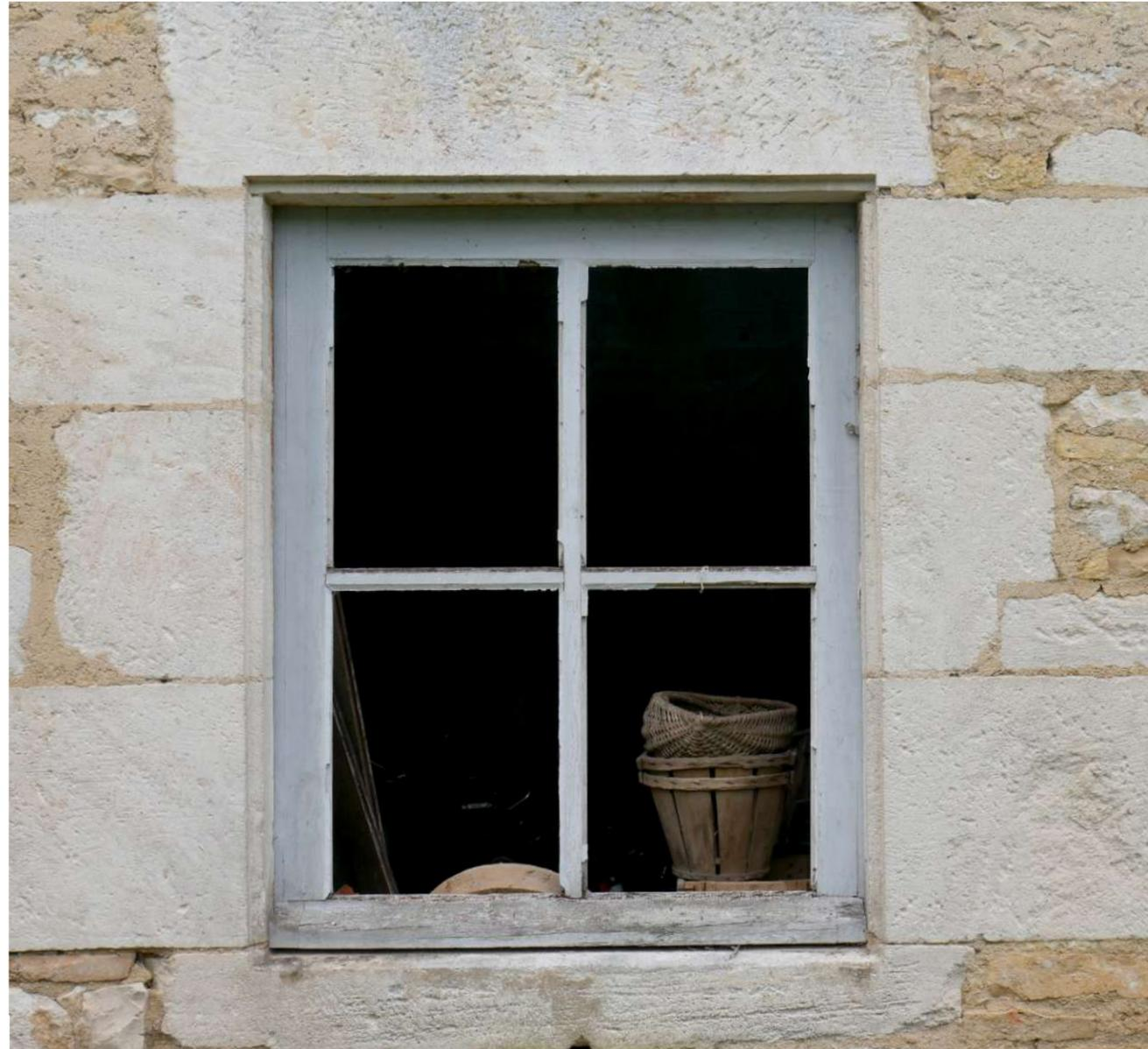
Traditionnellement en Haute-Marne, la fenêtre est réalisée en bois, un matériau adaptable et durable. Le travail de la fenêtre participe de façon essentielle au caractère de la façade. L'analyse du dessin de la fenêtre permet, notamment, d'appréhender sa période de conception : les fenêtres à meneau caractérisent le XVI<sup>e</sup> siècle comme les petits carreaux représentent le XIX<sup>e</sup> siècle.
