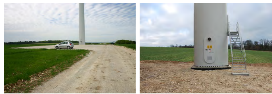
Fig.7. Exemples de piste d'accès et de plateforme d'un parc éolien
