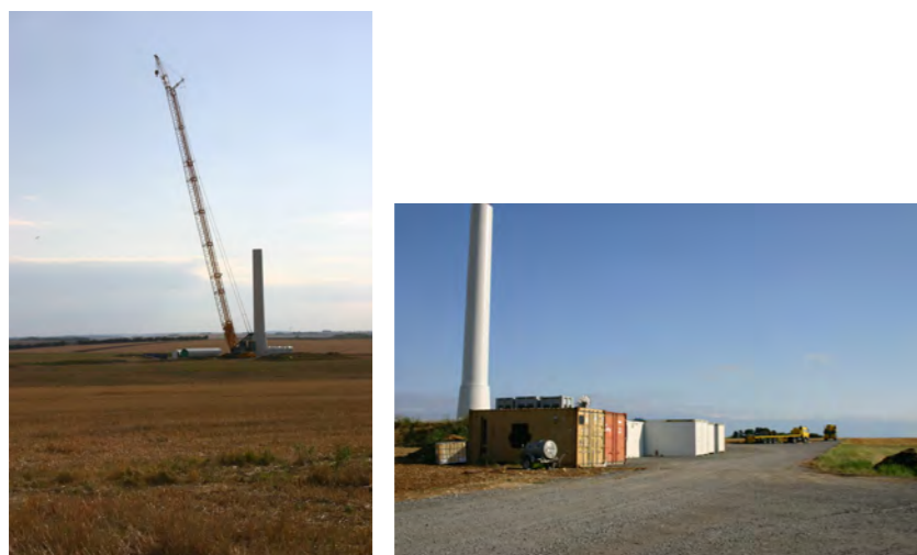
Fig.5-6. Exemples de chantier de construction d'un parc éolien
