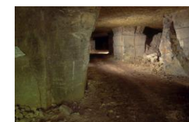
Carrière souterraine à l'abandon à Aulnois-en-Perthois F. Schwaab Source : DREAL Lorraine
