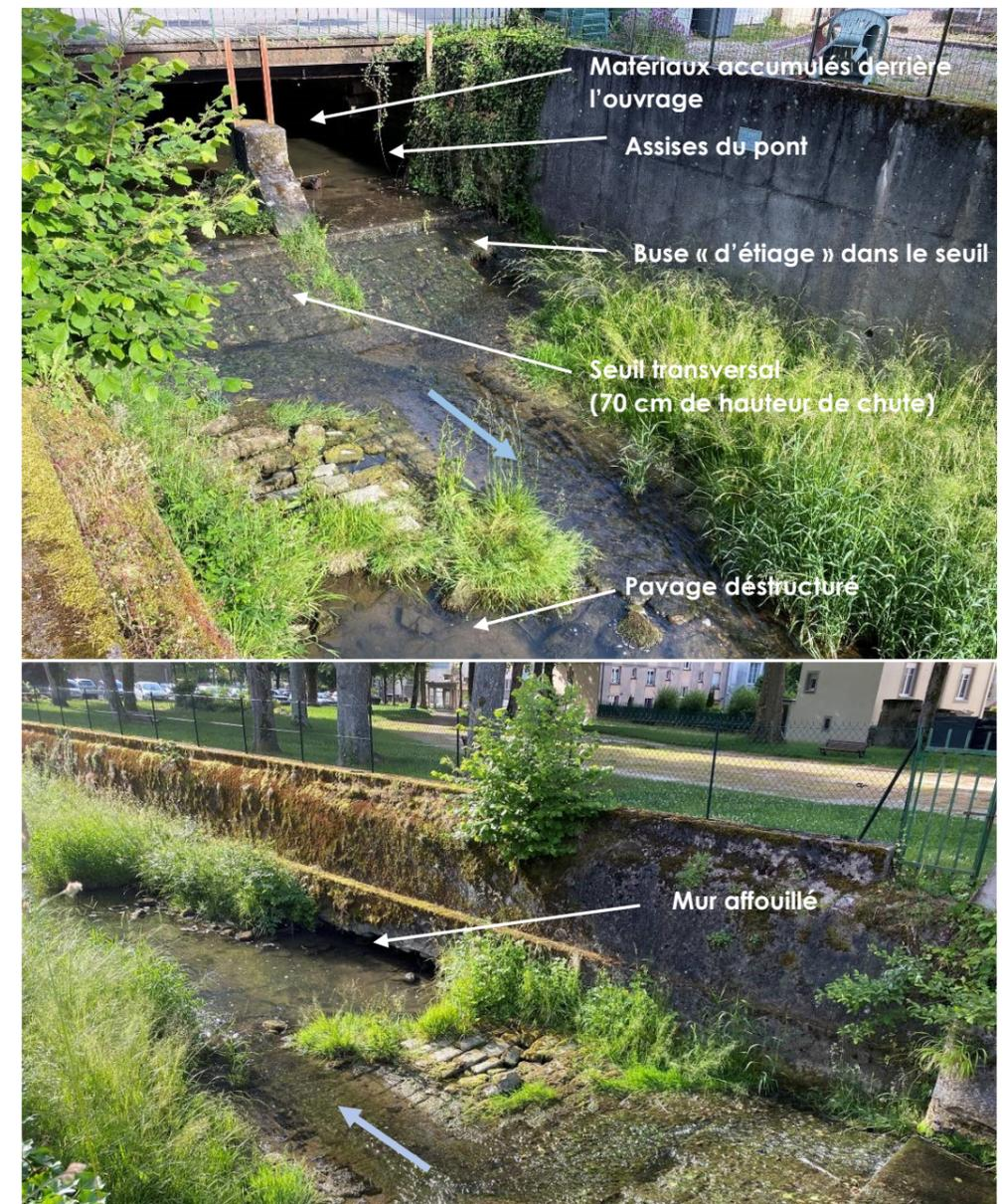
Figure 3 Vue de l'aval du seuil de Borne (images du haut) et de son aval immédiat et rive droite (image du bas) – (Clichés BIOTEC - 2022).
