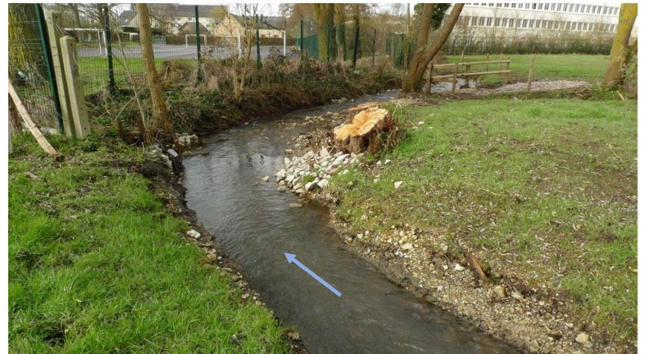
Figure 9 Effacement du seuil de Livarot (dept 14) sur le cours du Douet Fleury, par arasement en mise en scène de matériaux caillouteux d'apport sans micro seuil. Image avant travaux, pendant les interventions et une année après. Conception et maîtrise d'œuvre : Equipe d'ingénieurs d'études du bureau Biotec.
