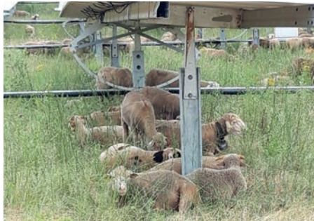
Photo 6 : Les centrales photovoltaïques génèrent de l'ombre pour les animaux (© Voltalia)
