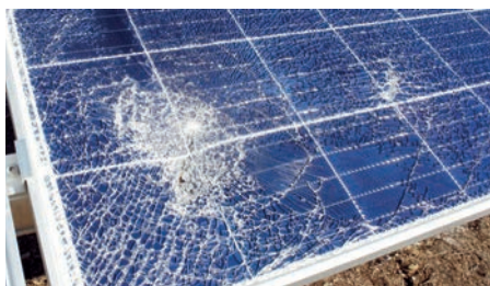
Photo 26 : Panneau photovoltaïque endommagé (© Andrei Merkulov/AdobeStock)
