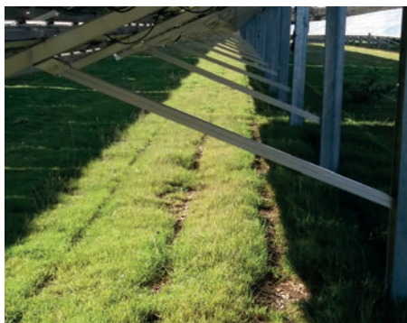
Photo 32 : Table fixe sur mono-pieu battu (© Idele)
