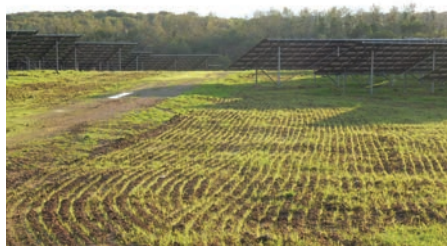
Photo 28 : Prairie semée dans un parc photovoltaïque (© Mortelmans)
