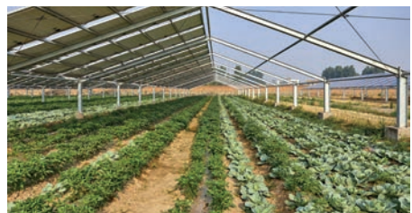
Photo 4 : Ombrières photovoltaïques mobiles installées au-dessus de cultures maraichères (© Jeson/AdobeStock)
