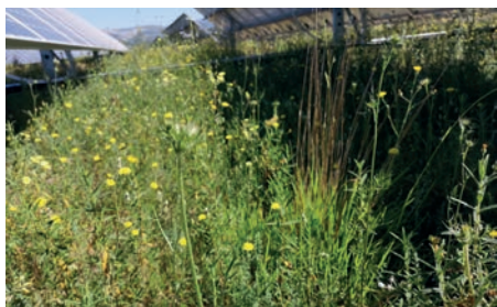
Photo 13 : Centrale photovoltaïque du Castellet (83) (© Voltalia)
