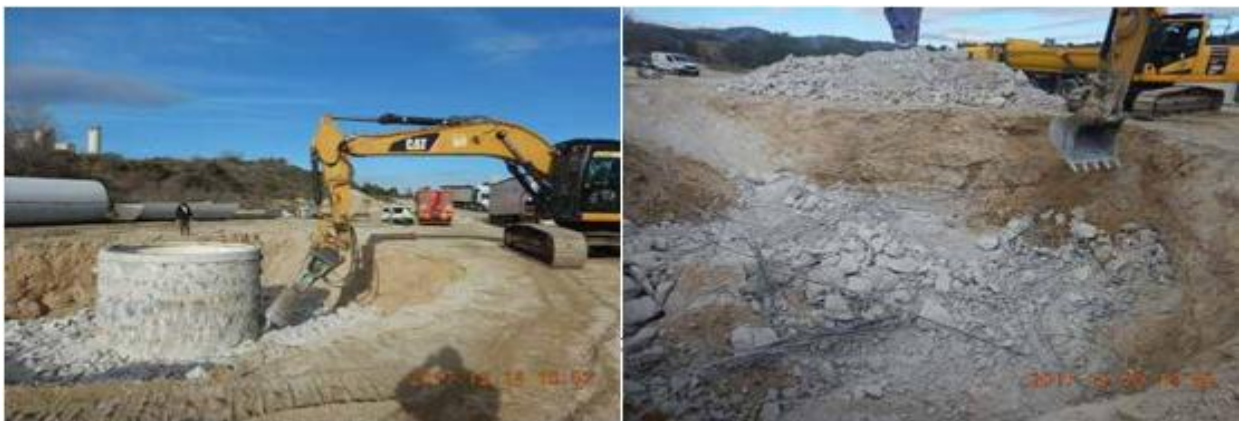
Figure 158 - Photos de démantèlement
