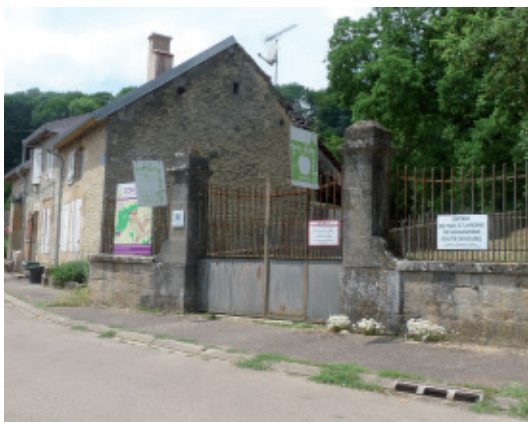
Fig VII.B.1.2 : vue du portail de la rue du Mont
