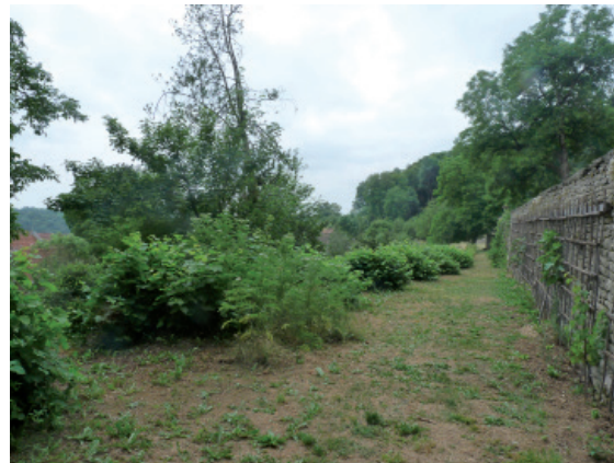
Fig VI.D.1 : vue de l'alignement A1
