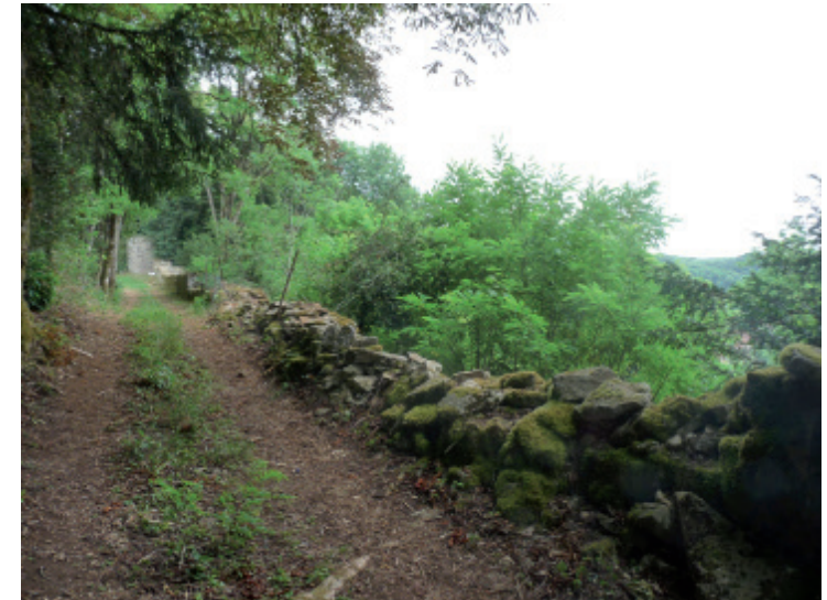
Fig VII.A.3.1 : vue du garde-corps de la Promenade du Belvédère - partie dégradée
