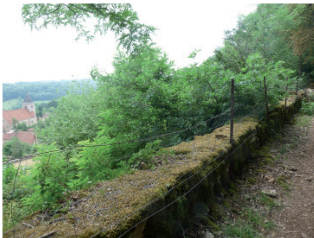
Fig VII.A.3.2 : vue du garde-corps - partie en état
