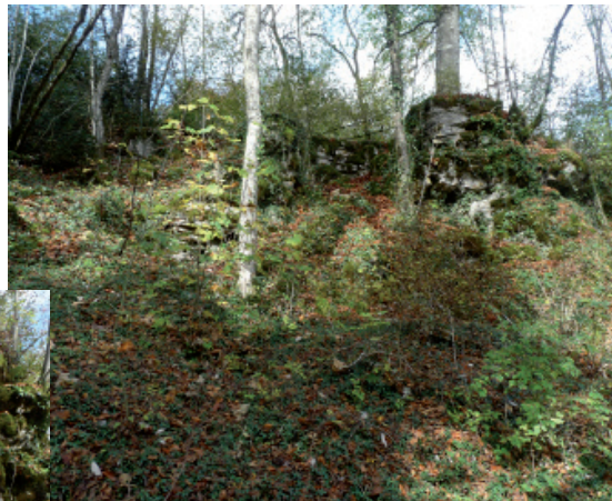
Fig IV.D.1 : vues de l'escalier dans la falaise
