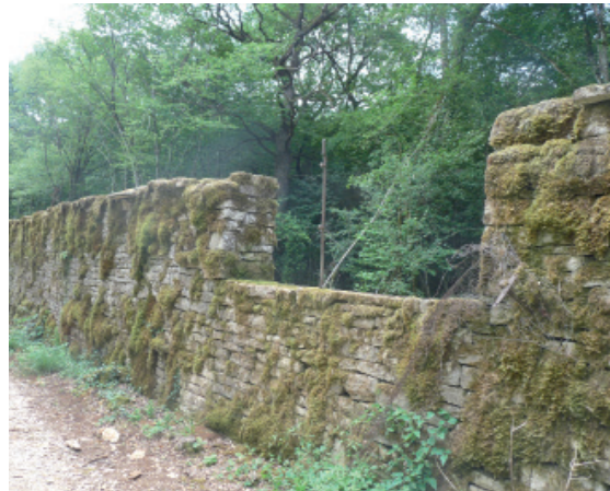
Fig III.C.1.f.6 : vue sur l'espace aménagé dans le mur en grille de vue
