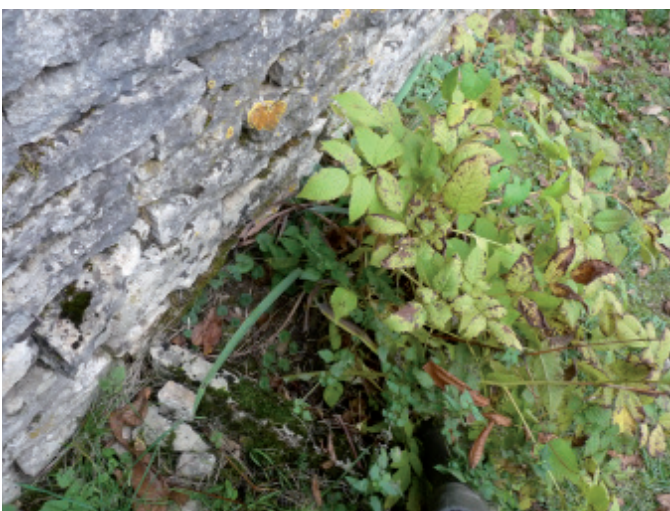
Fig III.C.3.a.7 : vue sur une jardinière ménagée au pied du mur rampe principale
