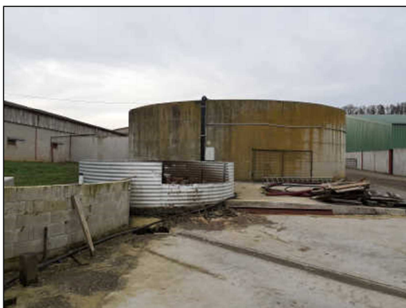
Pré-fosse et fosse aériennes de stockage des effluents liquides
