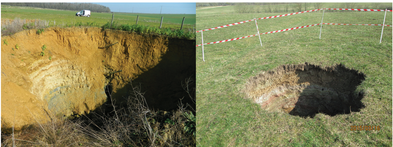
Effondrement de cavités à Courcelle-sur-Blaise (gauche) et à Laneuville (droite)
