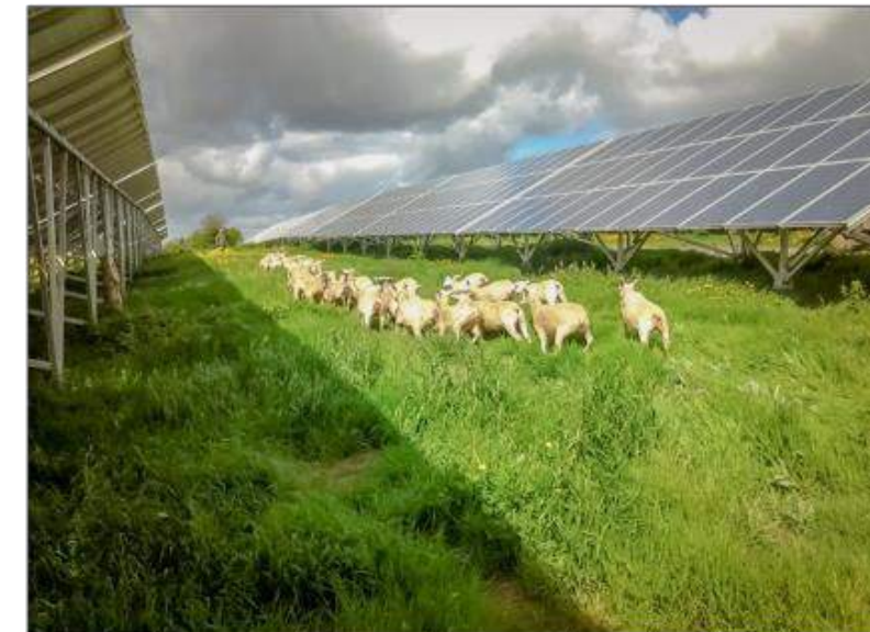
Exemple d'une centrale photovoltaïque au sol entretenue par pâturage
