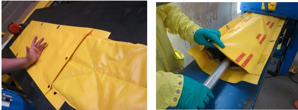
Fig. 28. Insertion et collage de l'enveloppe récupérée dans une enveloppe neuve
