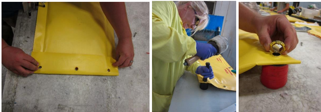
Fig. 29. Scellage de la nouvelle enveloppe et mise en place de rivets
