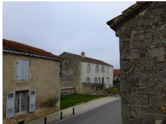
Fig. 126. Photographie (point n° 4) prise depuis le porche de l'église
