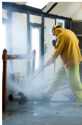
Fig. 24. Opération de décontamination
