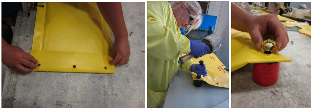
Fig. 28. Scellage de la nouvelle enveloppe et mise en place de rivets
