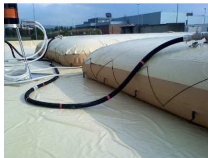
Fig. 20. Exemple de bâches souples de type PRONAL (différentes du projet UNITECH Services par leurs dimensions importantes et leur usage en extérieur)
