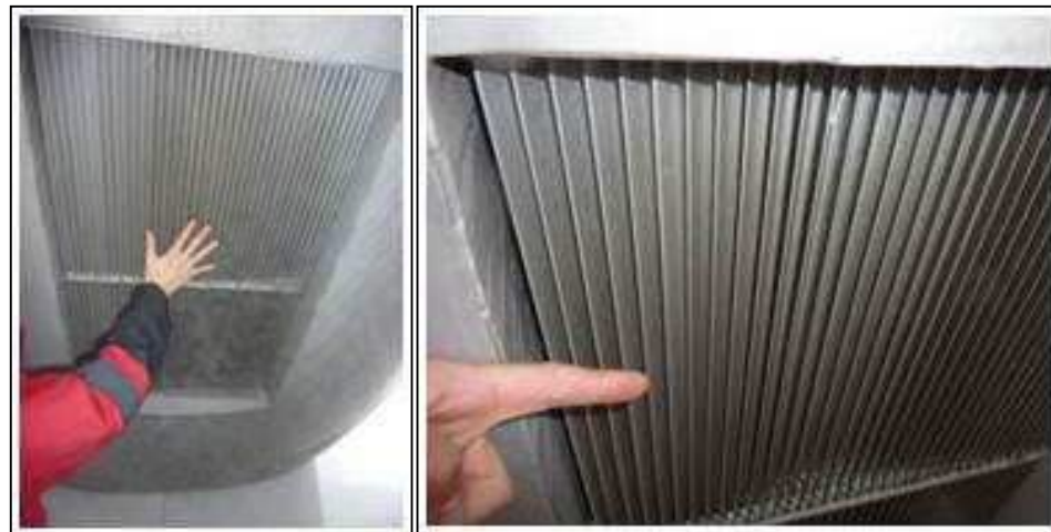
Figure 160 : Illustration d'un type de grille d'aération anti-intrusion
